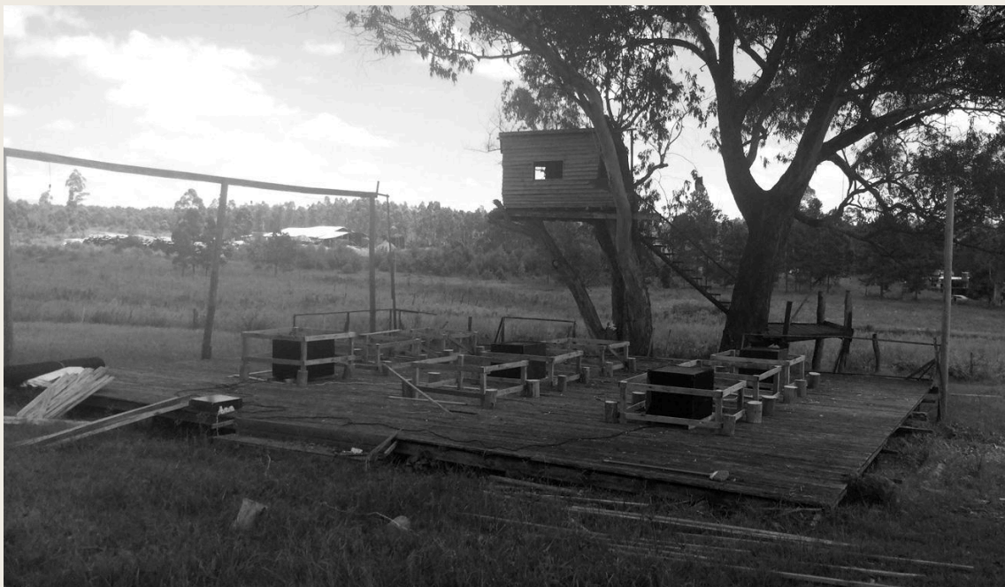
módulo de madera, red de alambre, tablas · plataforma en el campo
